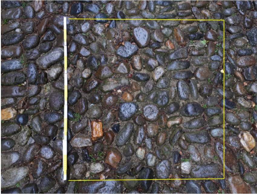
Fig. n. 283: acciottolato presente in Località Piazza di Biella; la presenza di ciottoli caratterizzati da una netta disomogeneità litologica testimonia la quasi sicura provenienza dal giacimento della Bessa. La presenza del metro facilita la conta del numero dei ciottoli per metro quadrato.
