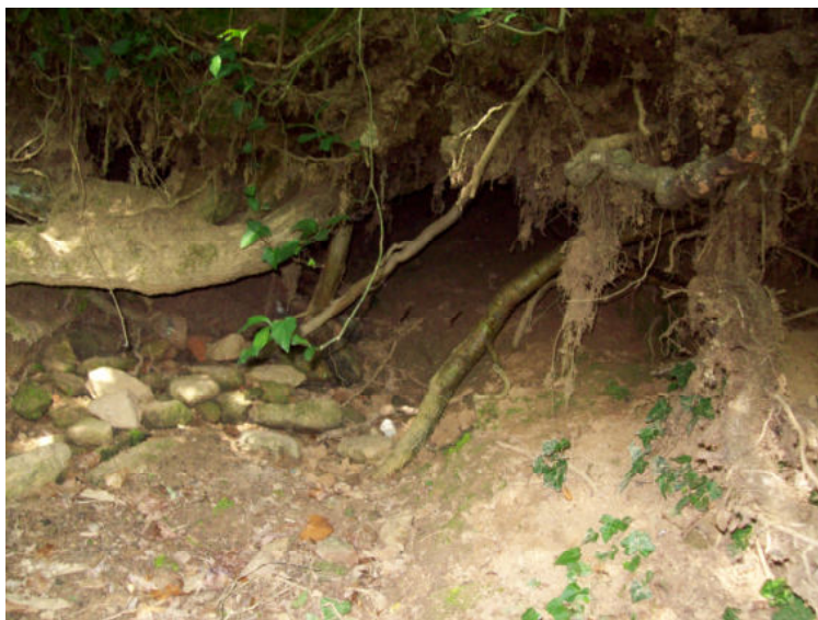
Fig. 169: piccola galleria a valle della zona crollata. Successivi crolli colmeranno la galleria e superficialmente si formerà una vallecola come primo passo per la formazione di una limitata idrografia superficiale.
