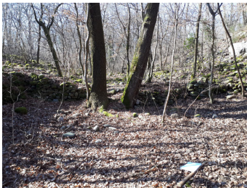
Fig. n.295 : punto (F) presenza di muratura in ciottoli con altezza variabile da 1,0 mt a 1,5 mt che si sviluppa sia trasversalmente alla valle e lateralmente sia sul versante destro che sinistro per interrompersi in corrispondenza del punto 003 (Percorso delle incisioni rupestri) per poi riprendere sino al punto (H) per una lunghezza totale di circa 140 mt.
