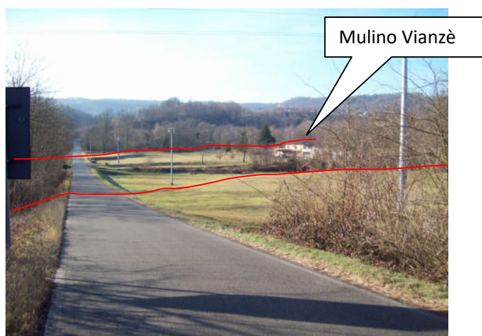
fig. n. 72: Strada Cerrione – San Sudario, la linea rossa contorna il margine superiore del solco d'erosione formatosi con la piena catastrofica del 1994. La profondità della rapida erosione è stata di circa 2 metri. Il Torrente Olobbia ed il Rio Della Valle Sorda hanno unito i loro alvei formando un unico torrente largo un centinaio di metri che ha distrutto la strada.
