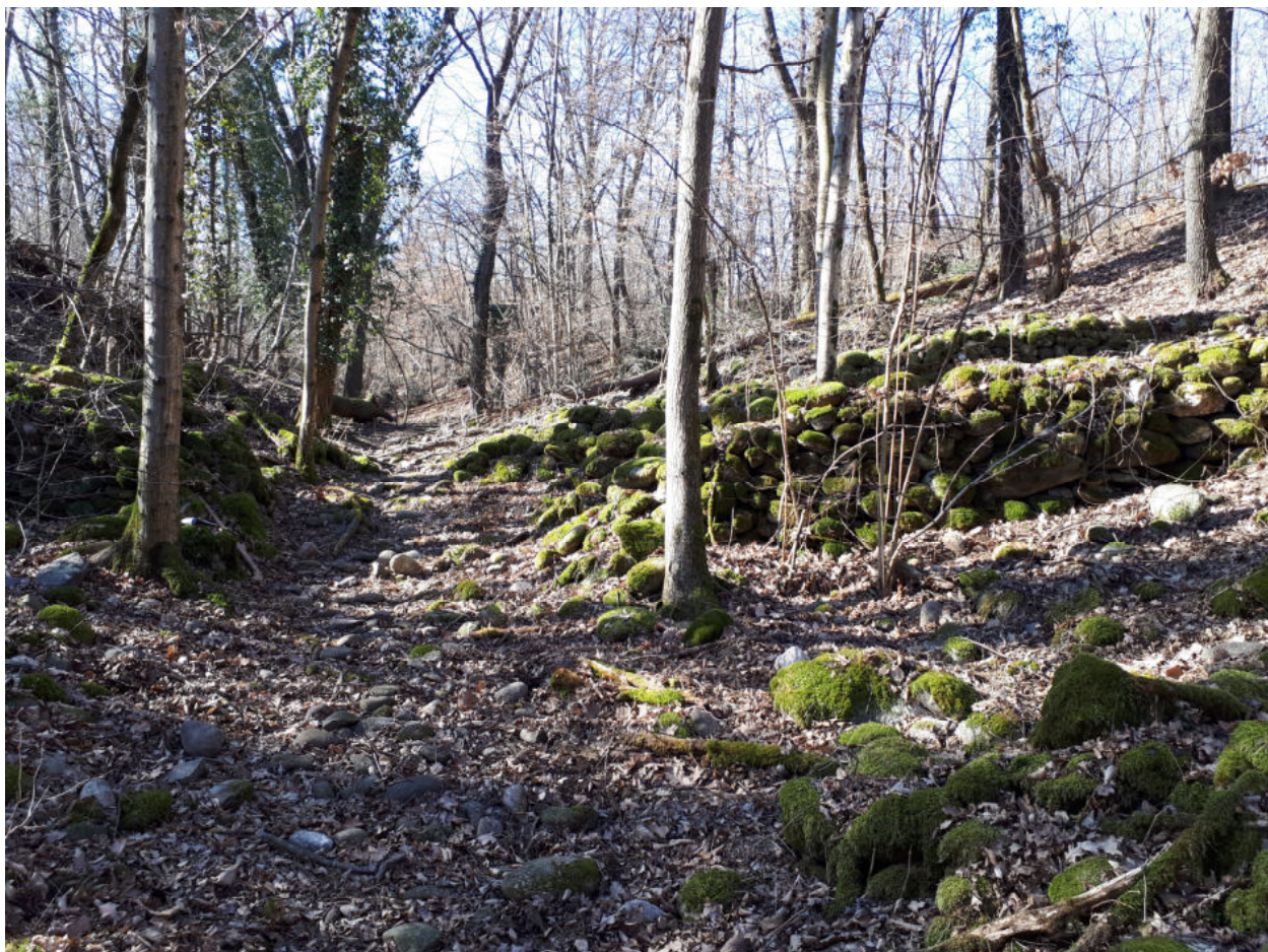
Fig. n. 293 : struttura muraria di sbarramento descritta nella precedente Figura.
