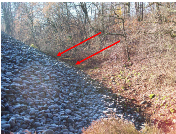
Fig. n.67: Bunda parallela al percorso "Ciapej Parfundà" sul fondo della quale sono presenti pozzi entro i quali si sente scorrere l'acqua ( Frecce rosse, in corrispondenza palina n. 11). Il rilievo sulla destra non ha subito rimaneggiamenti antropici significativi poiché è ancora presente una notevole componente terrosa e sabbiosa al contrario del rilievo a sinistra.
