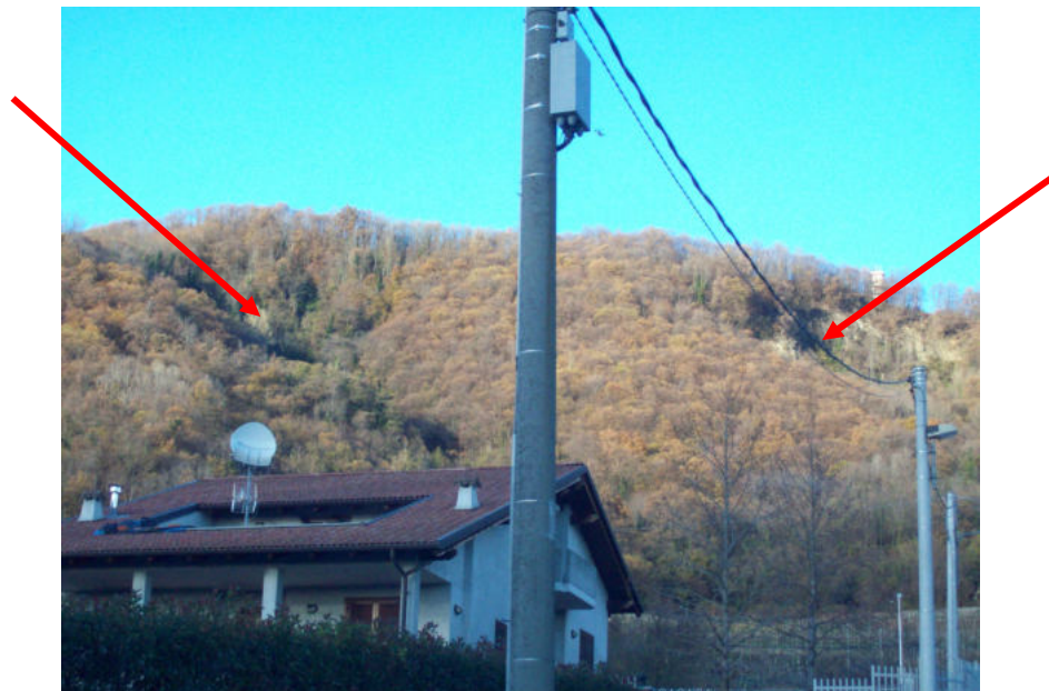
Fig. nn. 77-78 : imponenti dissesti franosi a monte di Bollengo e Palazzo Canavese generati da emergenze idriche sia localizzate che diffuse che saturano il versante rendendolo instabile. La causa non è certamente la rottura di un antico canale come sostenuto dall'Ing. Micheletti.
