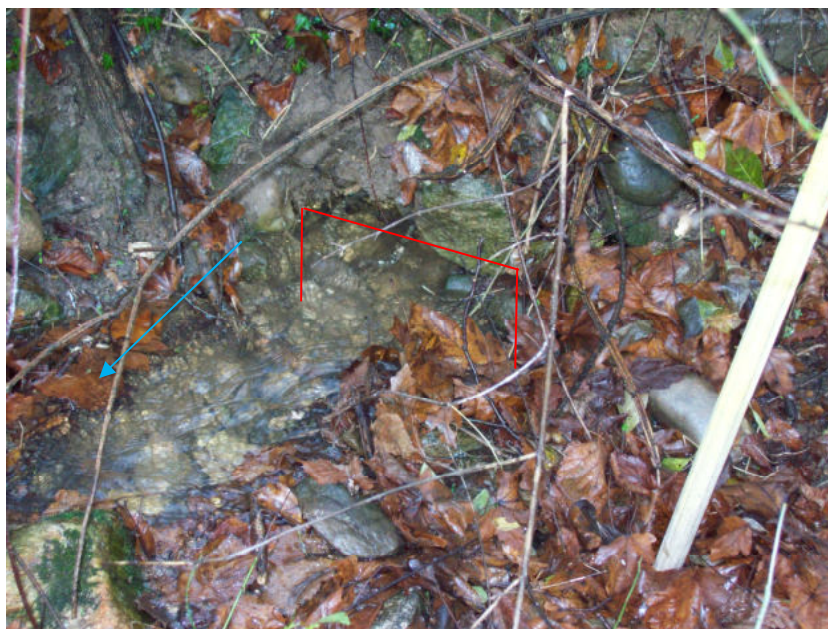
Fig. n. 83: Emergenza localizzata da una traccia di canalizzazione alla base di una vecchia muratura a secco.
