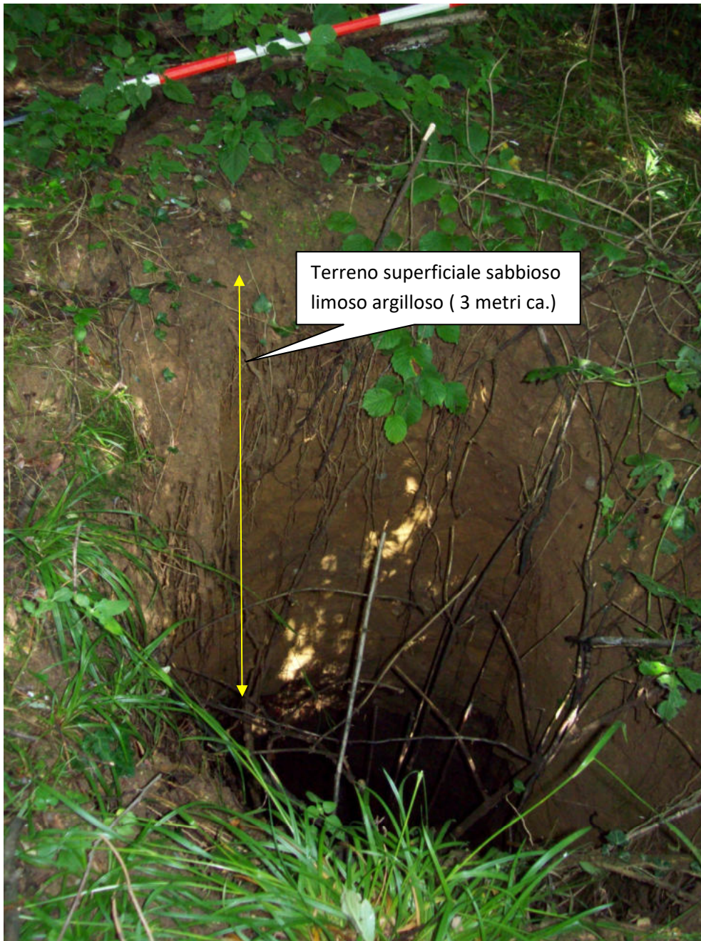
Fig. 172: Sink Hole visibile in Bessa in prossimità del Centro Visite. Diametro 2 metri circa, profondità 5 metri circa.
