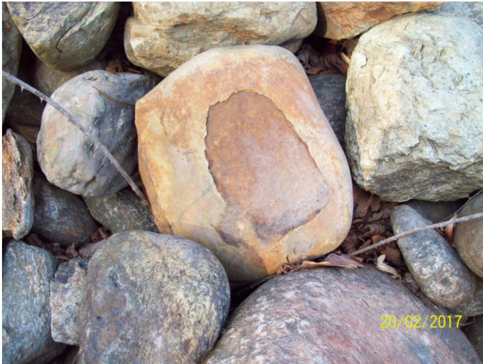
Fig. n.214: Bel esempio di esfoliazione su roccia silicea; il surriscaldamento della superficie e la sua diversa dilatazione termica rispetto alla parte più interna ha portato allo stacco netto della parte più superficiale del ciottolo.
