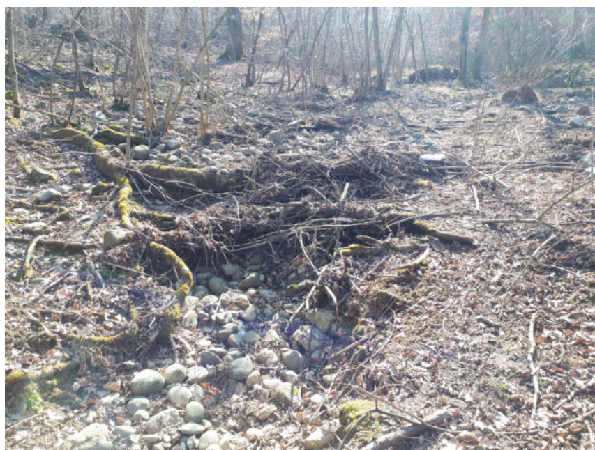
Fig.299 : recente erosione di fondo, in base all'altezza dei residui vegetale si può dedurre che l'altezza del flusso idrico sia stata di 40 cm circa.
